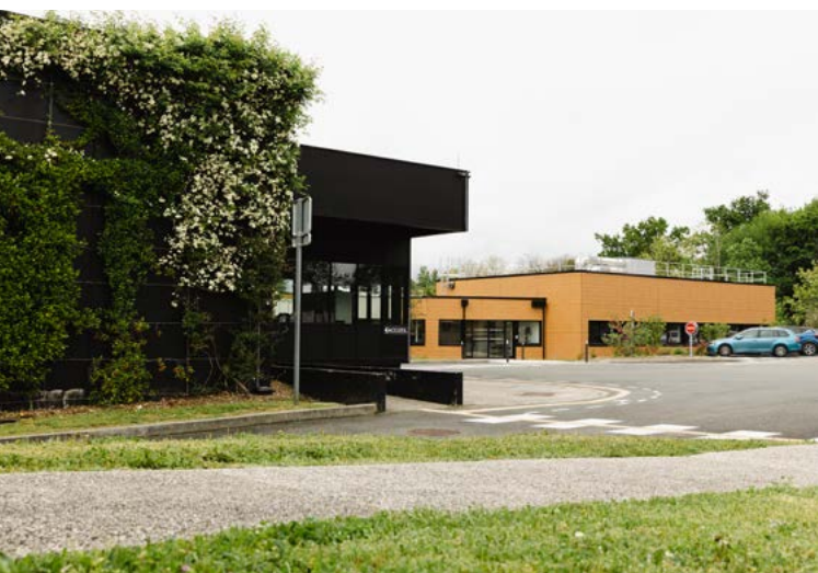
Vue extérieure du bâtiment du Datacenter
